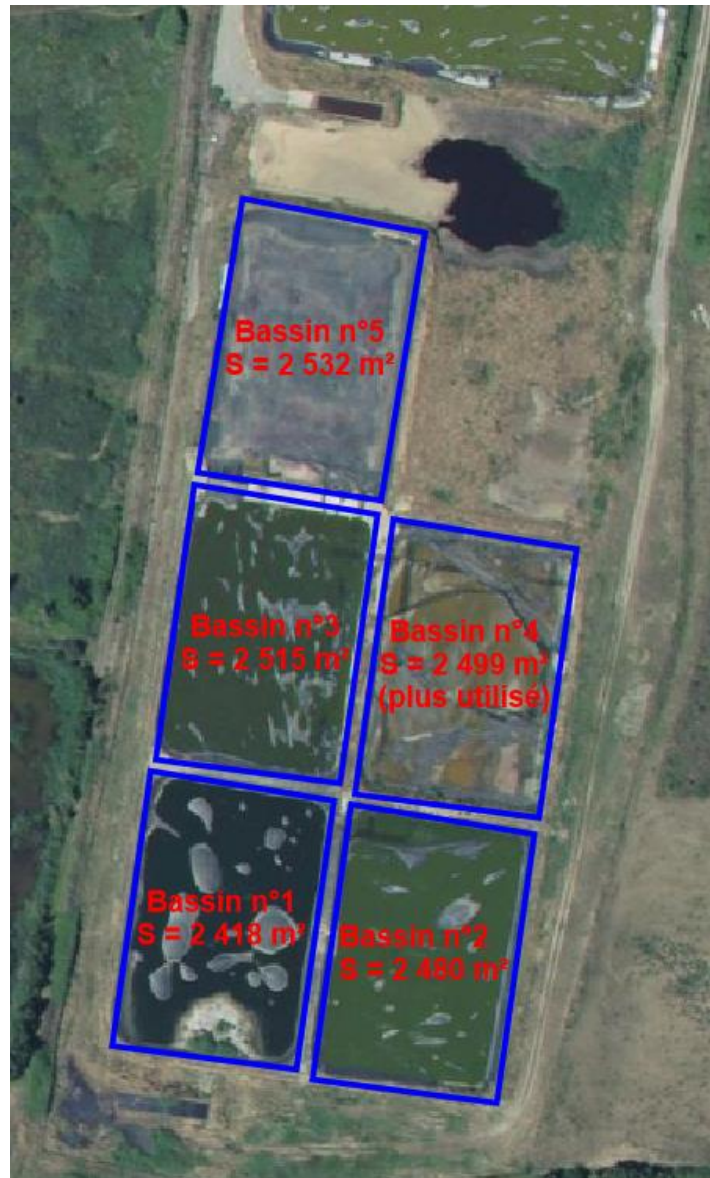
Figure 1 : Les 5 bassins d'évaporation naturelle de la cave La Vigneronne
